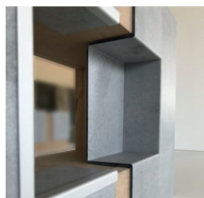
Revêtement d'une niche: 1 plaque pliée latéralement, 1 plaque pliée 4 fois
