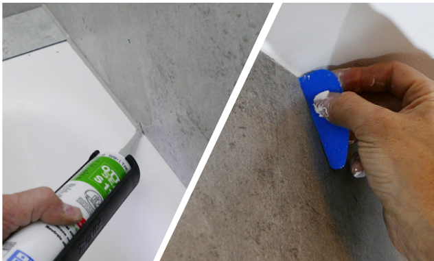
17. SCELLER LES JOINTS AVEC DU SILICONE ET RETIRER LE SURPLUS
