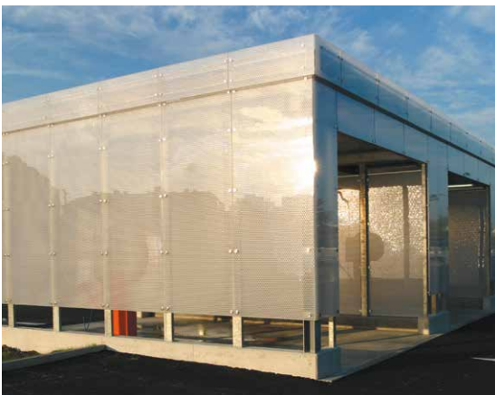
Aussenverkleidung; Waschstrasse/ Revêtement de façade; lavage automatique de voitures
