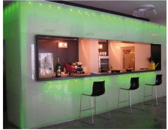
Hinterleuchtete Barverkleidung/ revêtement à éclairage indirect d'un bar
